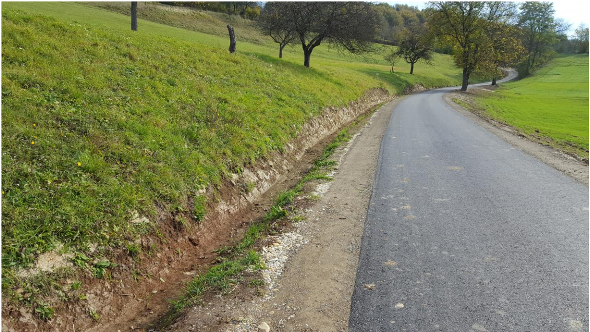
Slika 8: Obnovljen del vozišča JP 704741
