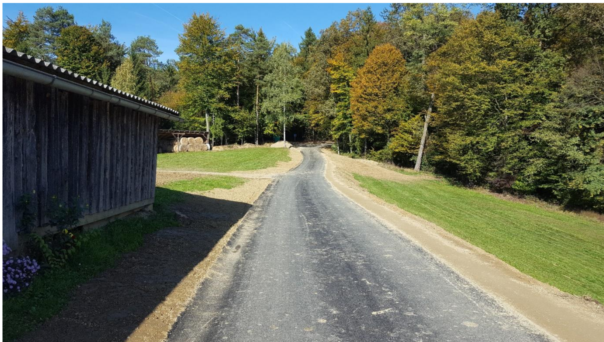
Slika 7: Obnovljen del vozišča JP 704822
