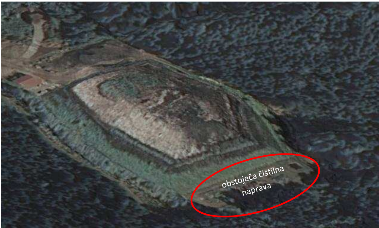
Slika 1. Pogled na zaprto odlagališče odpadkov
