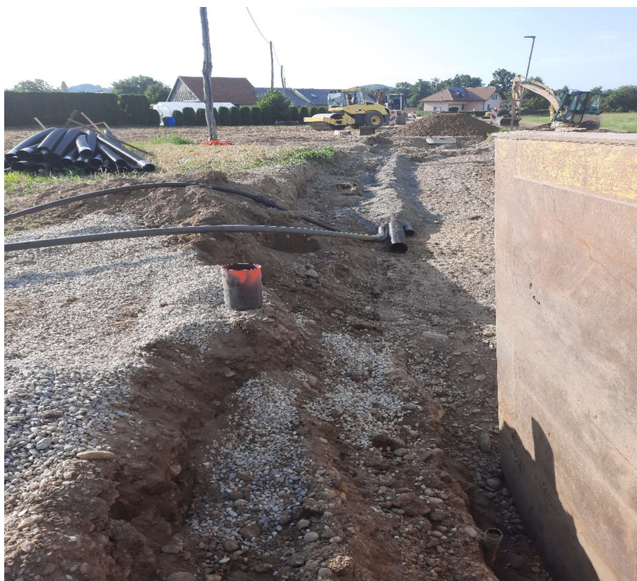
Slika 6: Izgradnja kanalizacijskega omrežja Lancova vas 1. faza
