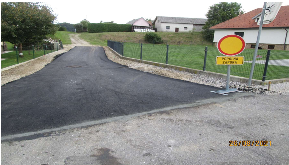
Slika 10: Izgradnja odcepa v Tržcu
