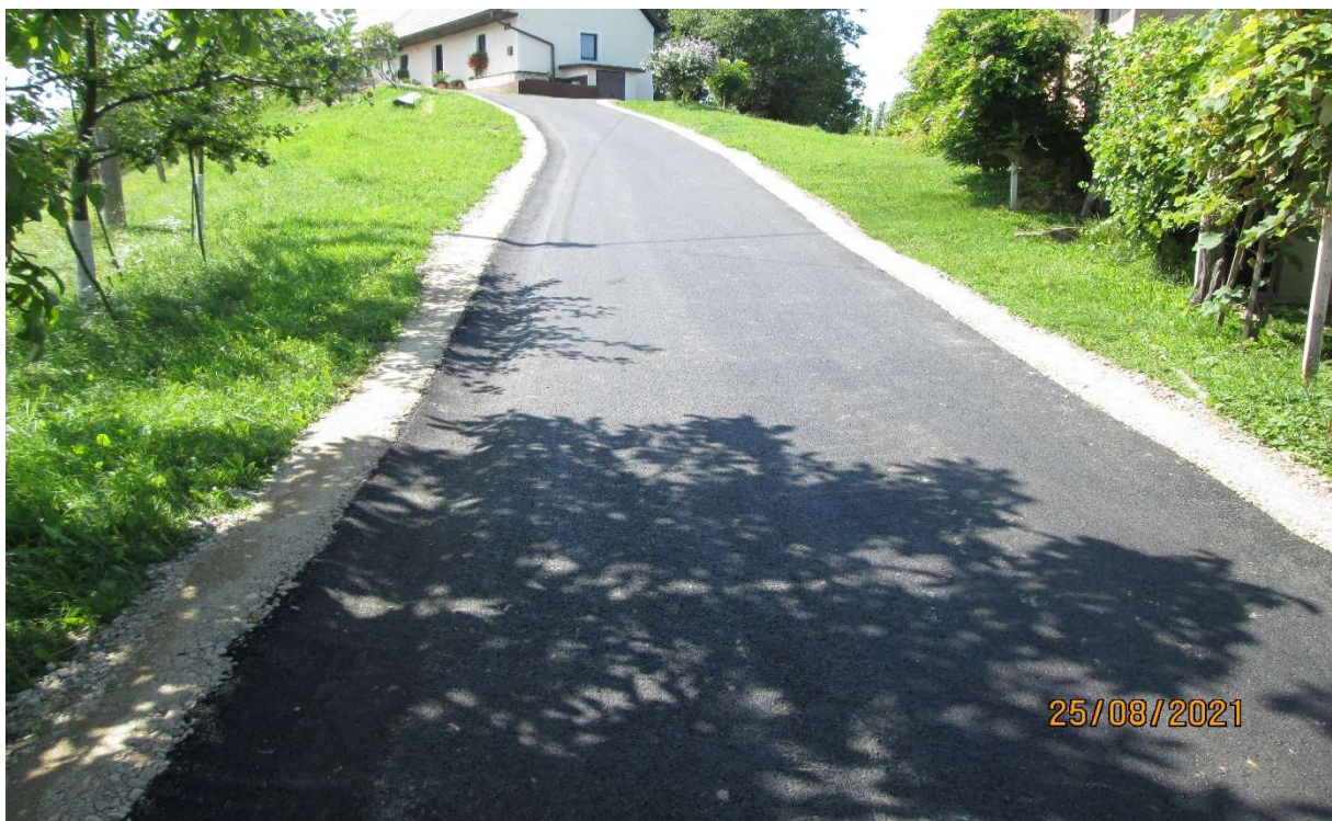
Slika 8: Izgradnja ceste proti Zg. Leskovec 24
