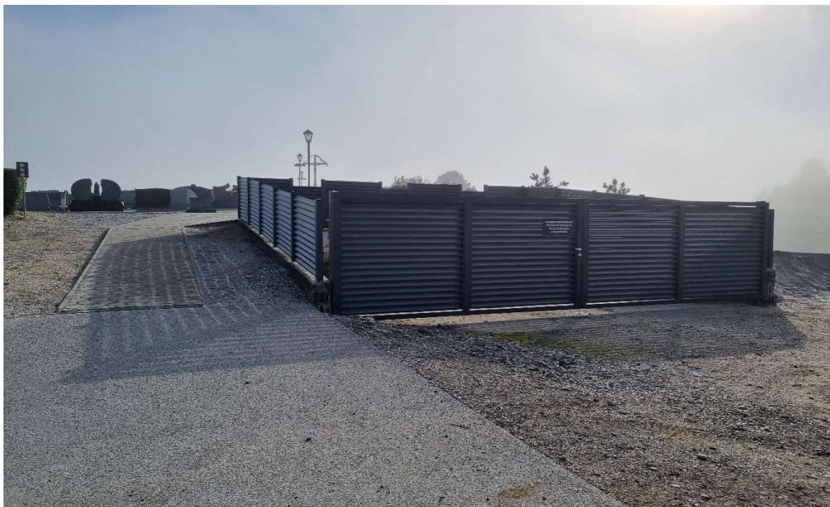
Slika 3: Postavitev ograje na pokopališču Leskovec
