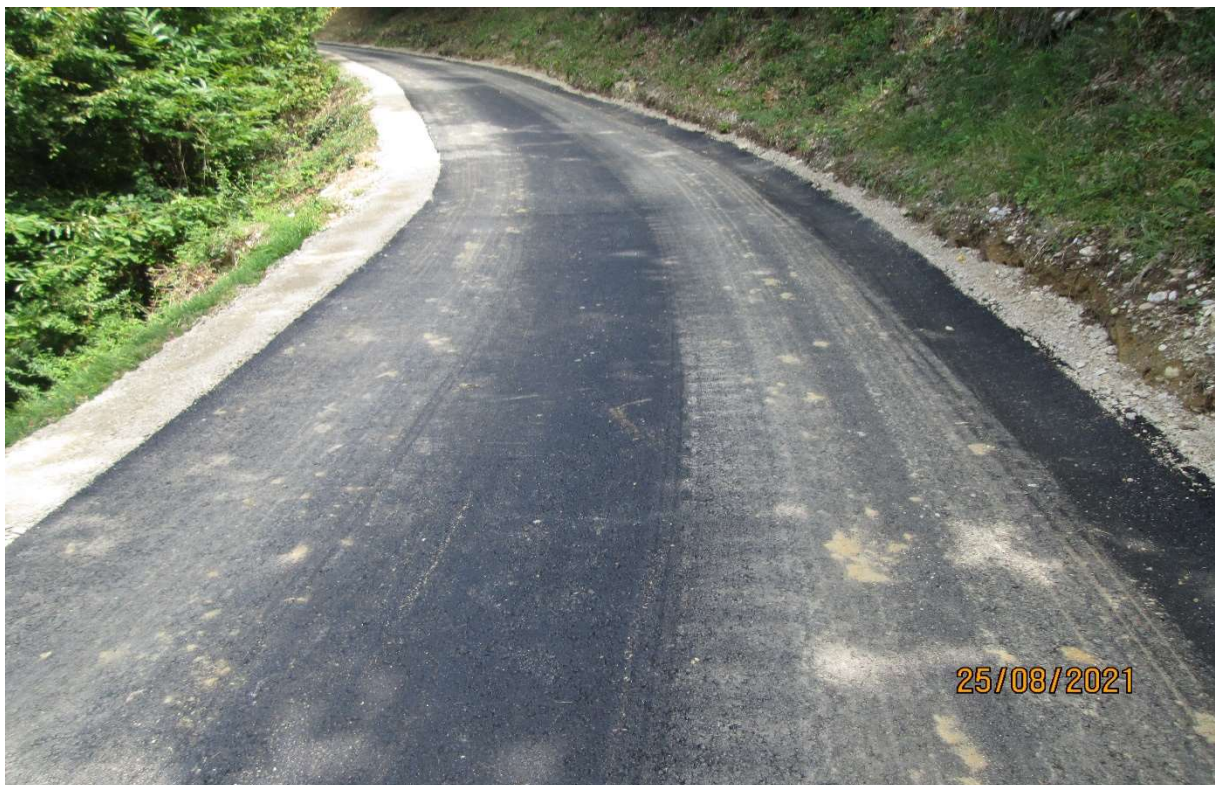
Slika 7: Izgradnja ceste na Avguštin
