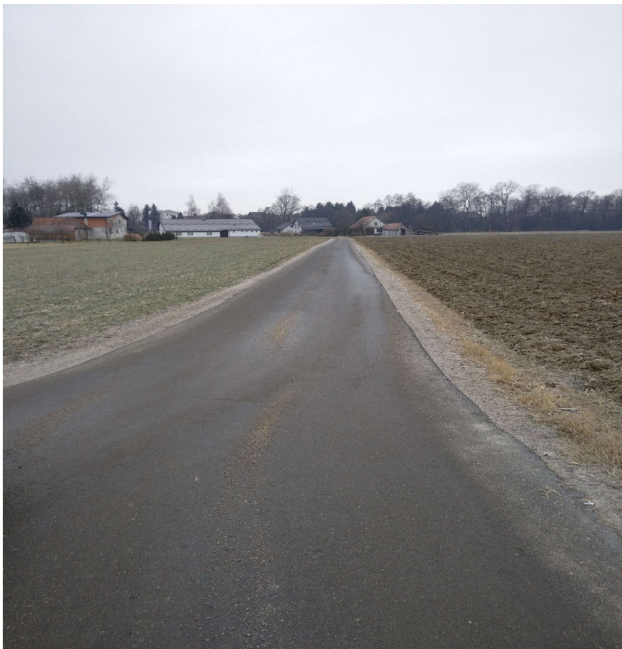
Slika 9: Izgradnja ceste v Pobrežju
