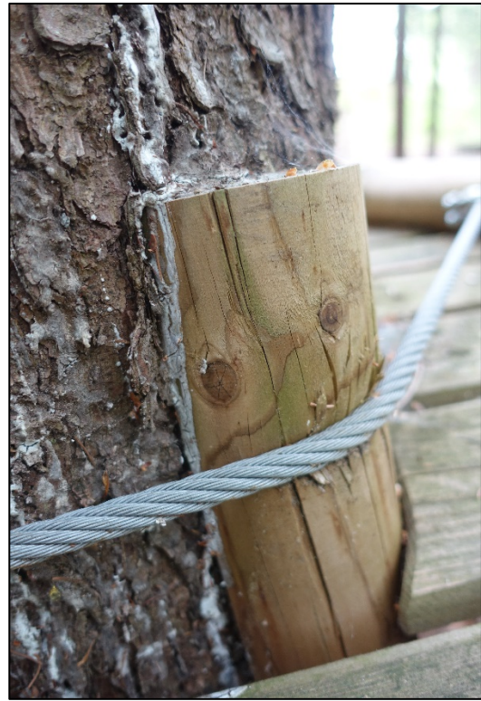
Slika 10: Premočno stiskanje polokroglic in začetek preraščanja skorje kot posledica nepopuščanja jeklenice štiri leta po namestitvi (foto R. Brus)
