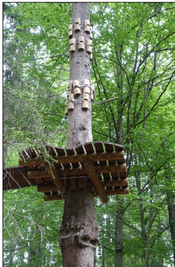
Slika 15: Smreka z vidnimi starimi poškodbami in elementi, nameščenimi v petih obročih (foto R. Brus)
