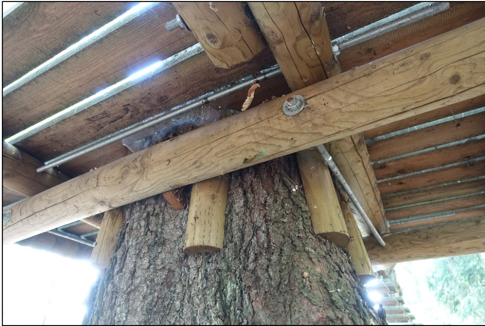
Slika 14: Pritrditev podesta na polokroglicah z vijaki pri smreki (foto R. Brus)
