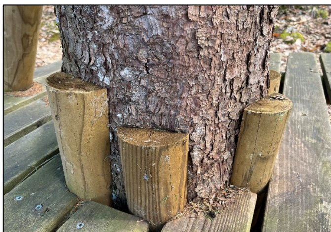
Slika 17: Močno stiskanje in začetek preraščanje polokroglic pri podestu štiri leta po namestitvi (foto R. Brus)
