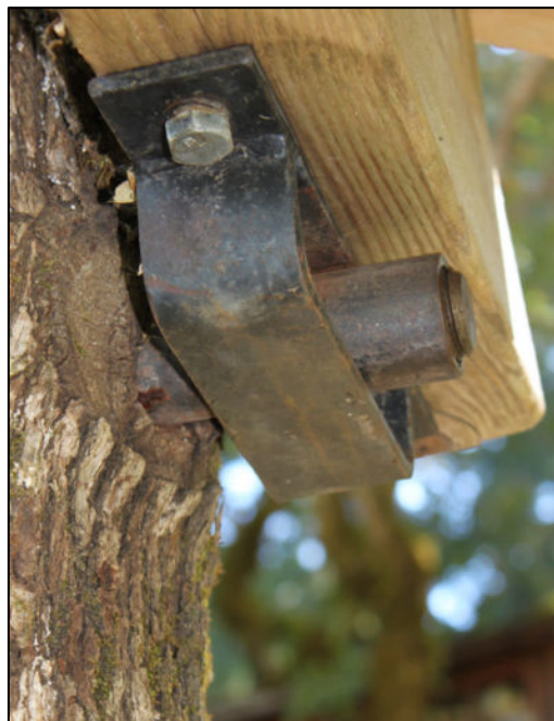
Slika 4: Pritrditev podesta z vijaki (Treehouse shop, 2023)
