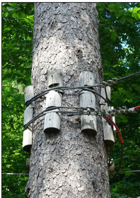
Slika 5: Pritrditev jeklenic na polokroglice (foto R. Brus)
