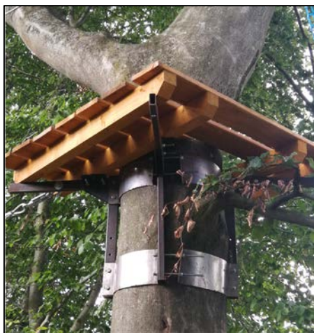
Slika 3: Podest s kovinskimi polkrožnimi objemkami (Kraj in sod. 2022)
