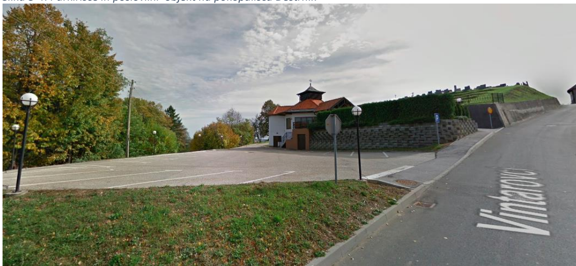
Slika 3-4: Parkirišče in poslovilni objekt na pokopališču Destriku
