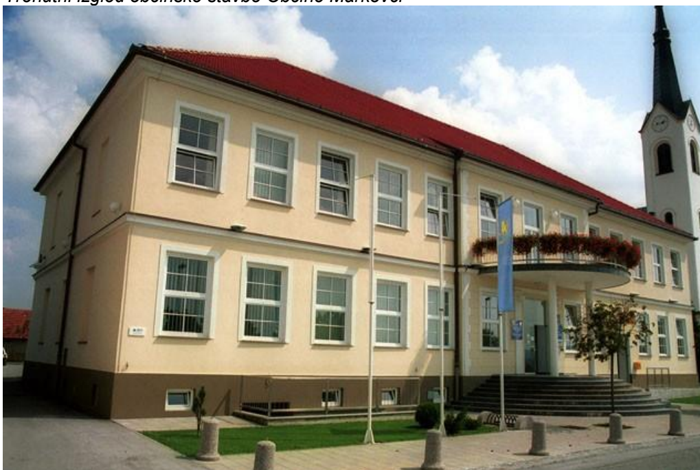
Slika 3: Trenutni izgled občinske stavbe Občine Markovci
