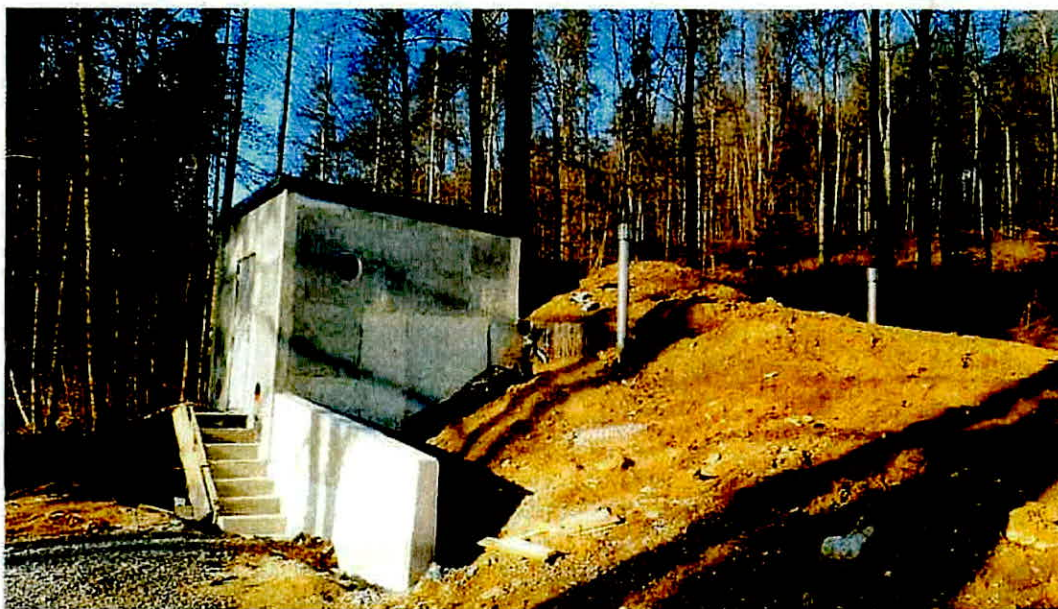
Slika 4: Obnova vodohrana Brezovica 2018
