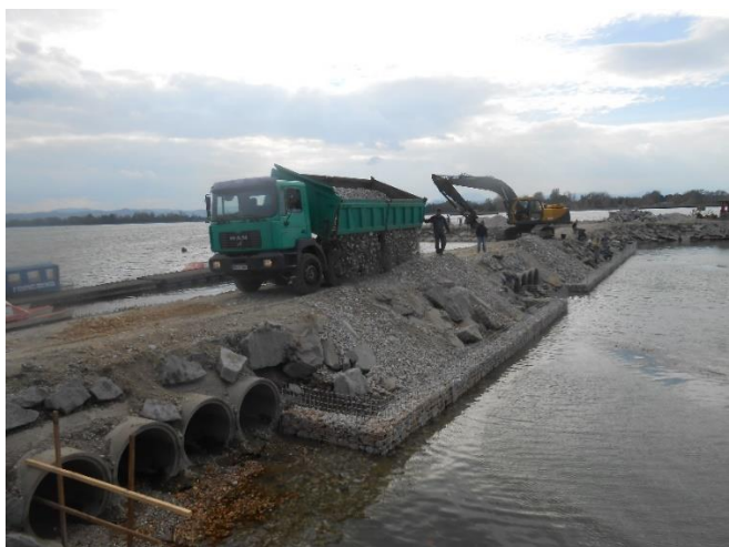
Slika: Sanacija nasipa pristanišča v letu 2013
