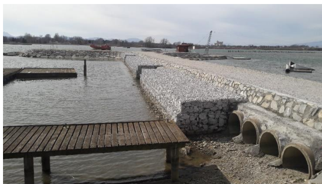
Slika: Ureditev gabionov na desni strani nasipa pristanišča v letu 2017
