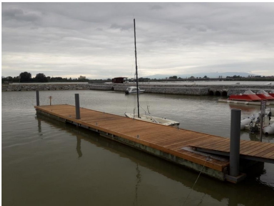
Slika: Obnovljeni stari pomoli v pristanišču Ranca
