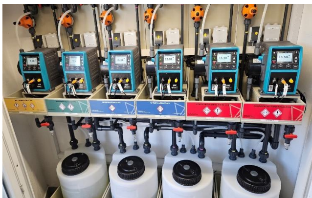
Slika 5: Sistem za doziranje kemikalij v Vodarni Gojka
