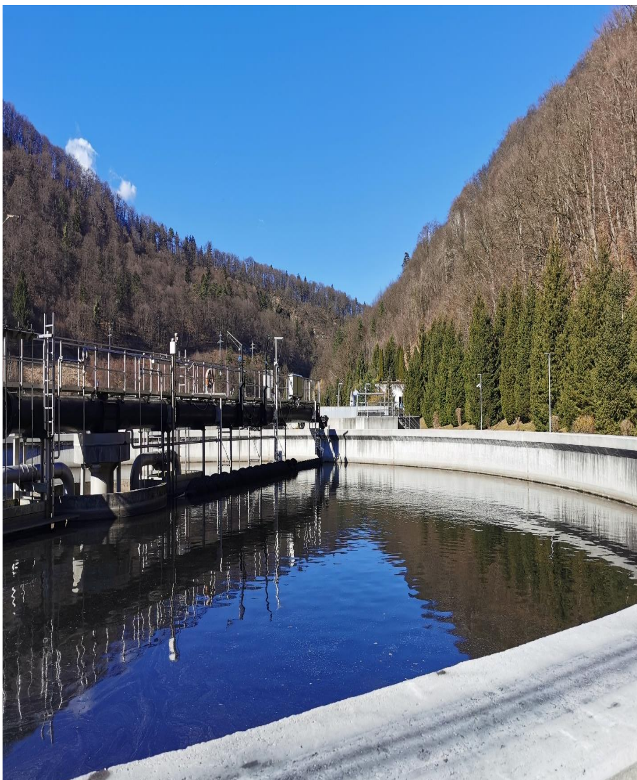
Slika 11: Naknadni usedalnik na ČN Celje
