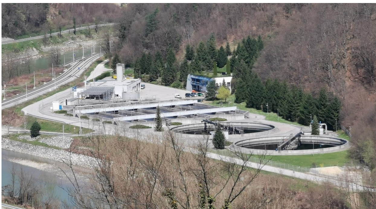
Slika 10: Čistilna naprava (ČN) Celje
