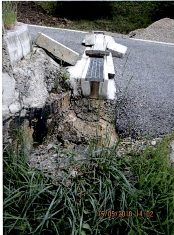
Slika 3: Izvajanje del v varovalnem pasu občinske ceste.
