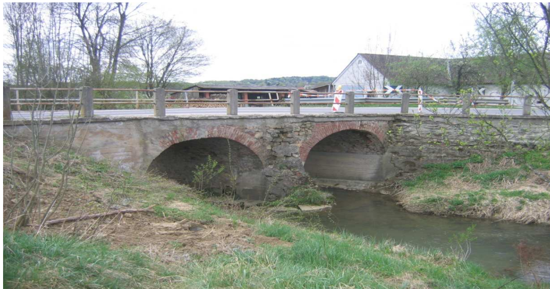
Slika 2 prikaz obstoječega stanja
