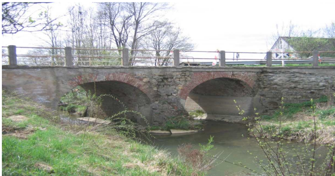
Slika 1 prikaz obstoječega stanja
