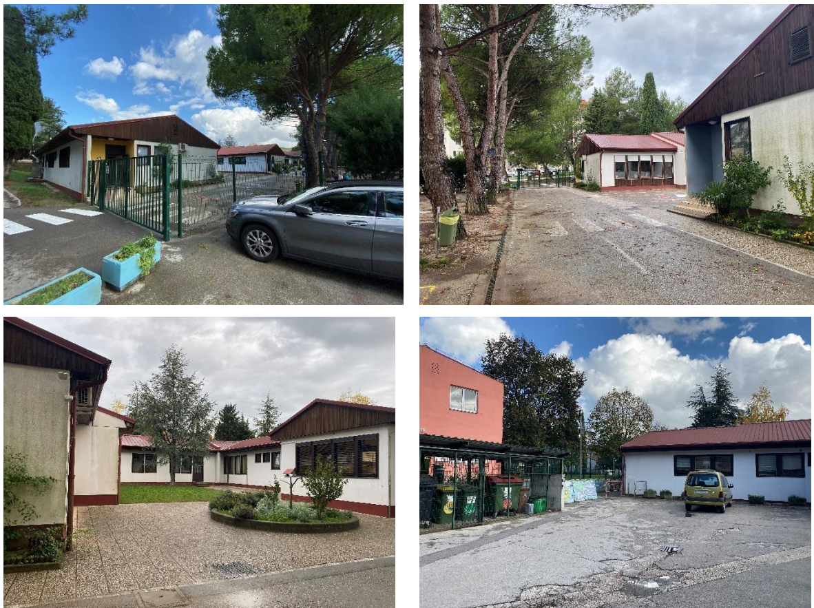
Slike 13 - 16: Stavba vrtca
