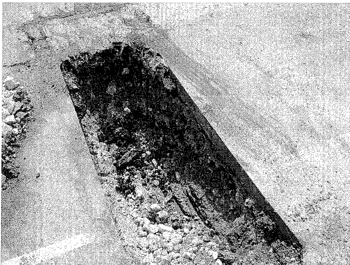
Slika 2: Izkop sondažne jame
