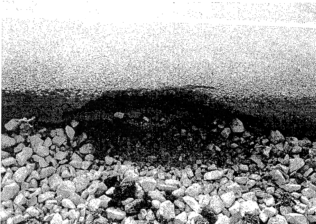
Slika 1: Krušenje asfalta na rokometnem igrišču OŠ Križe
