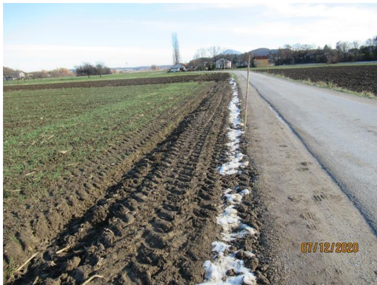
Slika 5: Stanje po sanaciji
