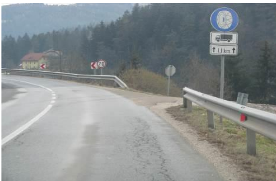
Slika 4: Obstoječi cestni priključek »Kefrov mlin«
