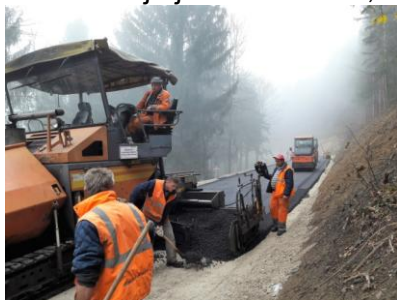
Sliki 17 in 18: Asfaltiranje dela lokalne ceste na Gorenje in končana dela
