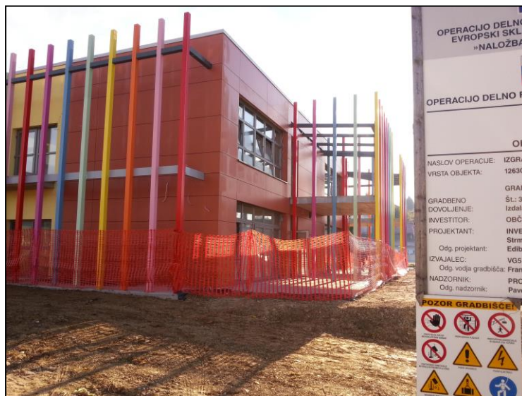
Slika 10: Gradnja novega nizkoenergetskega vrtca Benedikt
