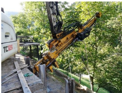
Slika 29: Vrtanje sider
