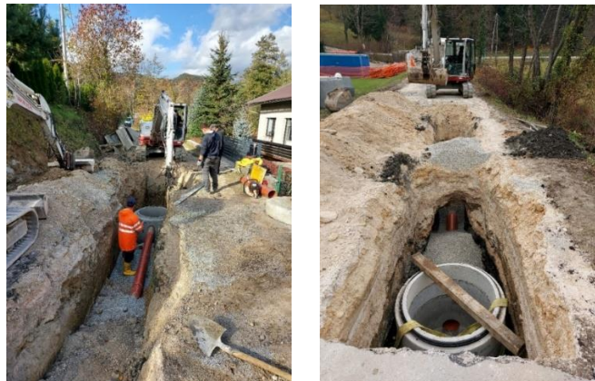
Sliki 58 in 59: Dela na kanalizaciji Vidner – Osredok
