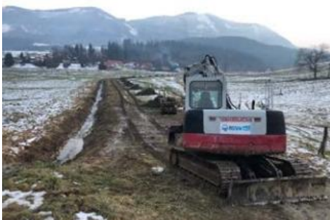
Slika 111: Poglobitev in čiščenje brežin Tesnice s pritokom iz Bukovelj
