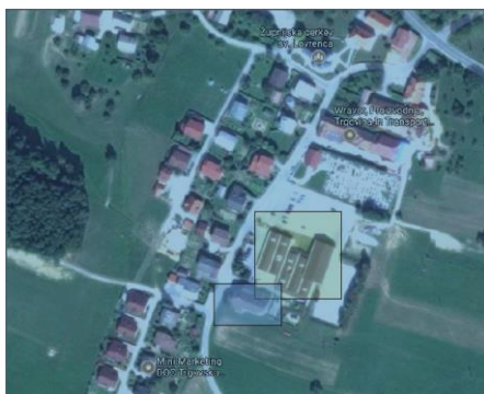
Slika 63: Območje izgradnje kotlovnice
