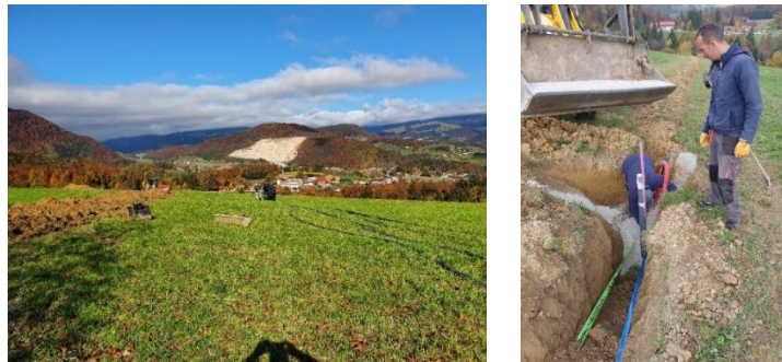
Sliki 55 in 56: Rekonstrukcija vodovoda v naselju Čretvež – Stranice
