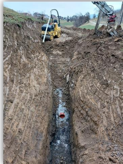
Slika 2: Dela na kanalizaciji, sklop 1
