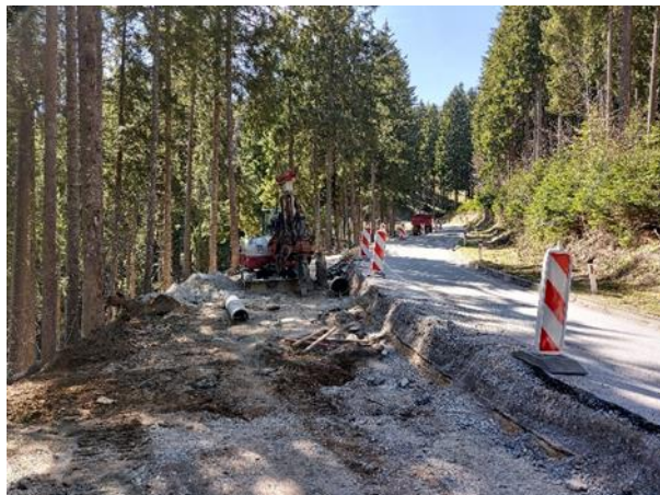
Slika 3: Dela na sanaciji plazu
