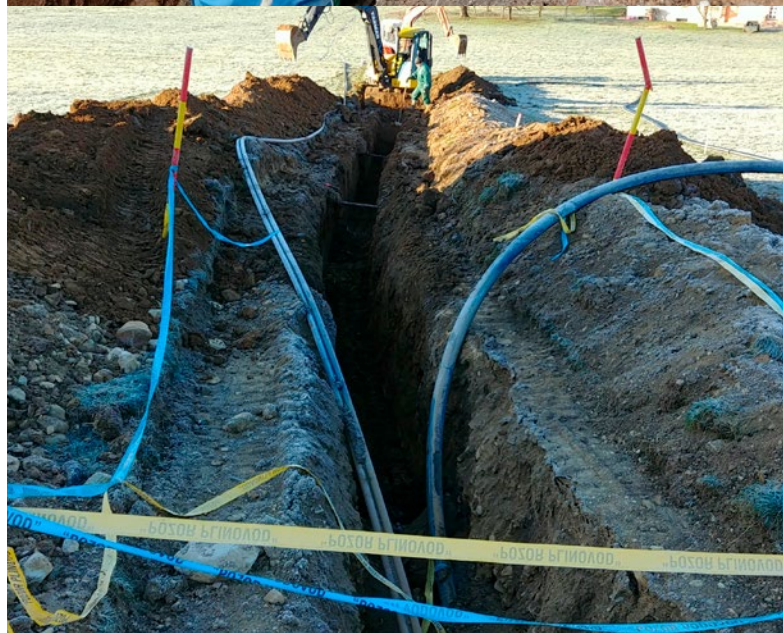
Obnova vodovoda Štibuh-Podgorska cesta in obnova vodovoda Lamp-Fišer
