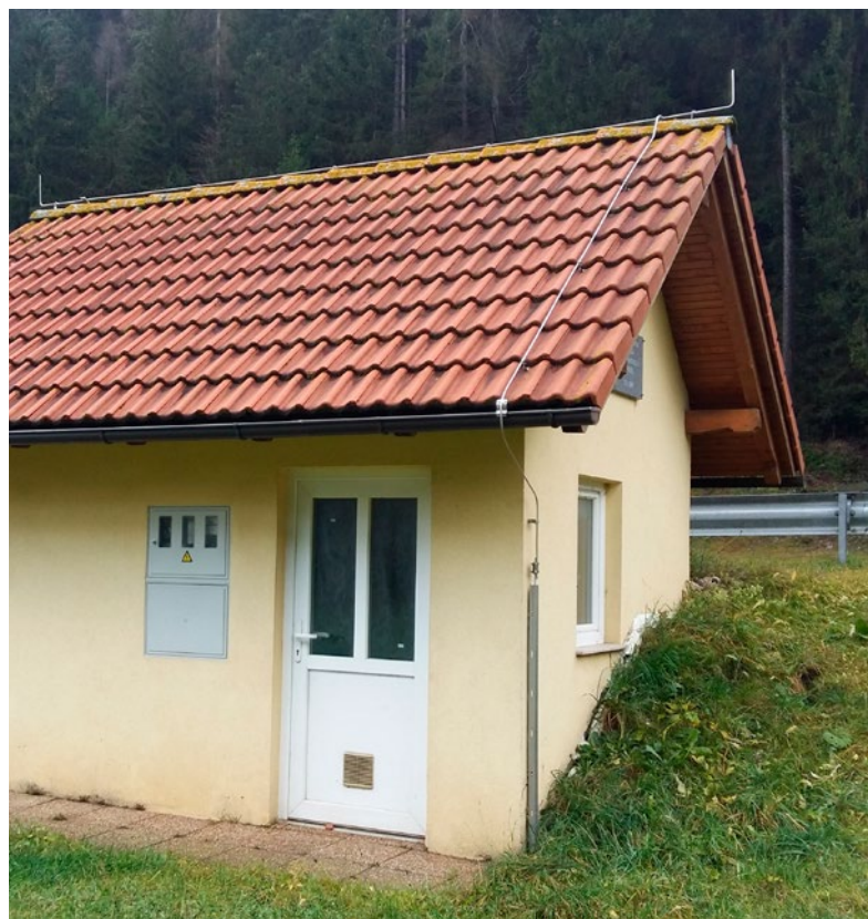
Mala hidroelektrarna v Suhem dolu
