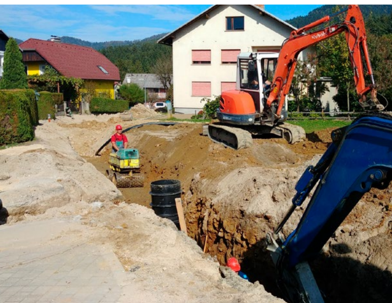
Pogled na gradbišče pri gradnji kanalizacije na Legnu
