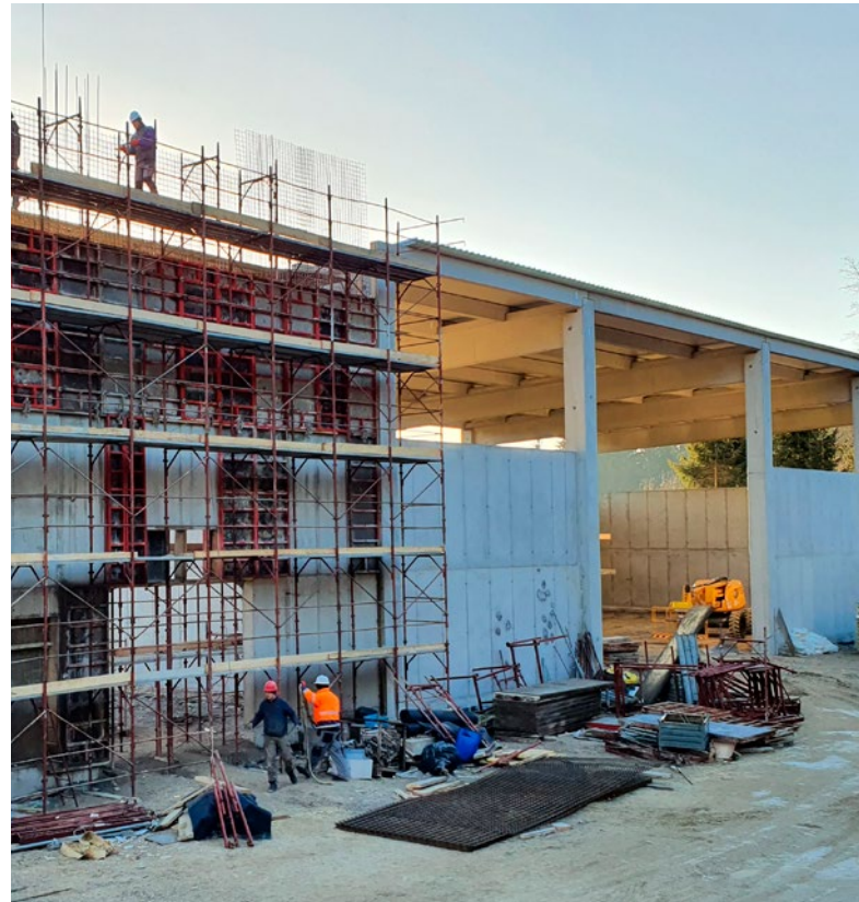
Gradnja kotlarne na lesno bio maso
