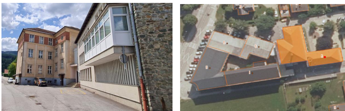
Slika 11: Objekt OŠ Janka Glazerja Ruše in njegova mikrolokacija Vir podatkov: Razširjeni energetski pregled OŠ Janka Glazerja Ruše, julij 2021
