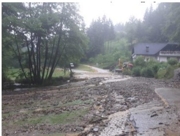
Slika 1: Preplavljanje in erodiranje LC 350361 na premostitvi potoka izpod Hudobnika v Breznici – pritok 1
