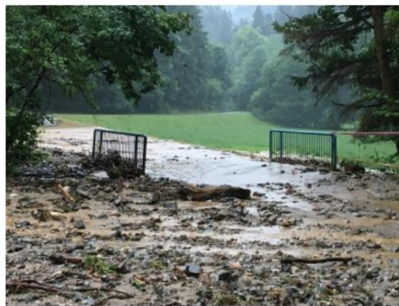
Slika 2: Preplavljanje in erodiranje LC 350361 na premostitvi potoka izpod Suhega vrha – pritok 2
