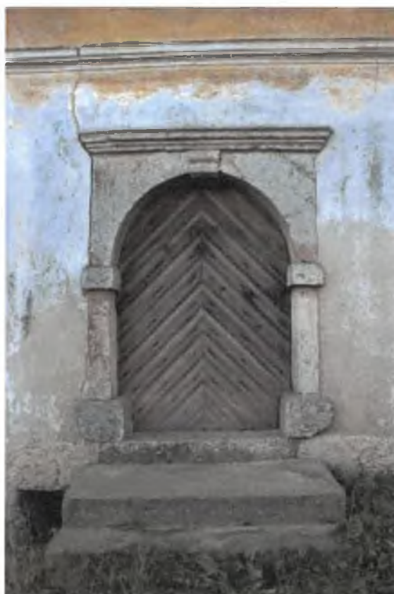
Slika 4: Vhodni portal iz škofjeloškega konglomerata.
