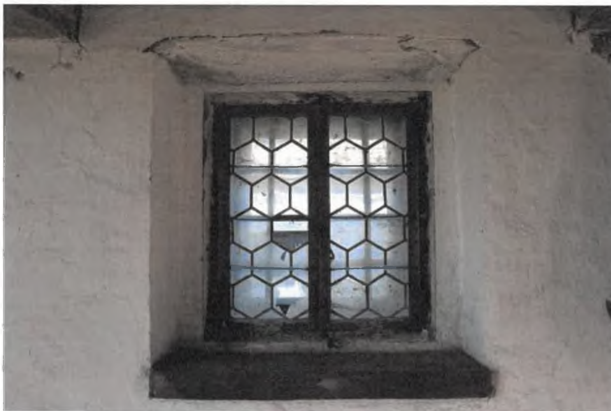
Slika 8: Okno v današnji garaži – pihana stekelca v svinčenih okvirčkih.
