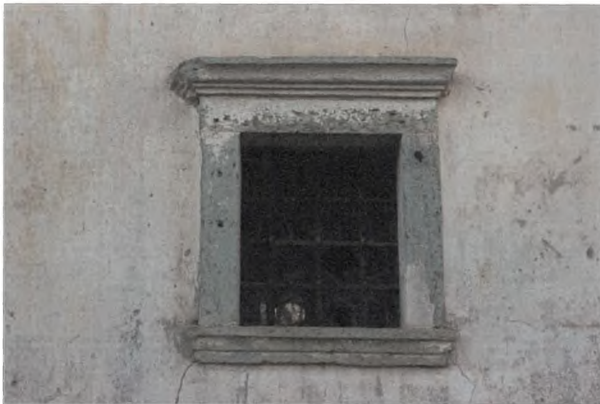
Slika 7: Okenski okvir iz tufa.
