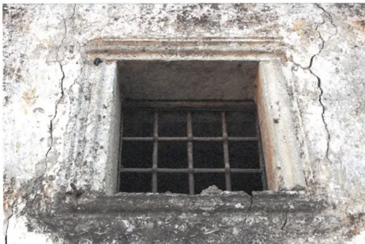
Slika 6: Okenški okvir iz škofjeloškega konglomerata.
