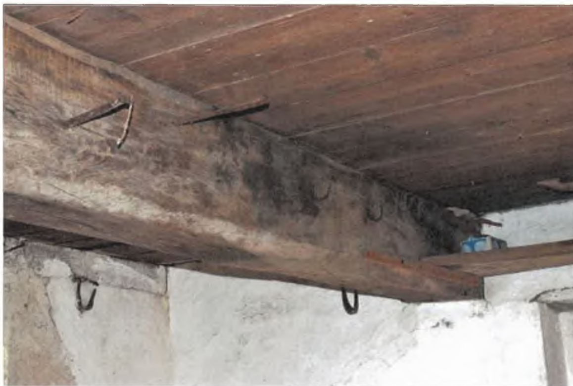
Slika 10: Lesen strop s hrastovimi stropniki v današnji garaži.
