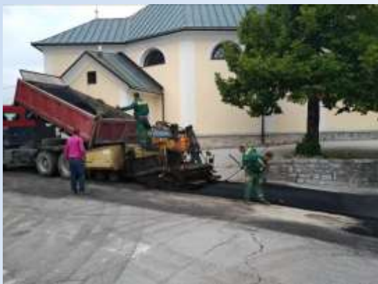
Slika 37: Asfaltiranje cestišča Sv. Gregor
