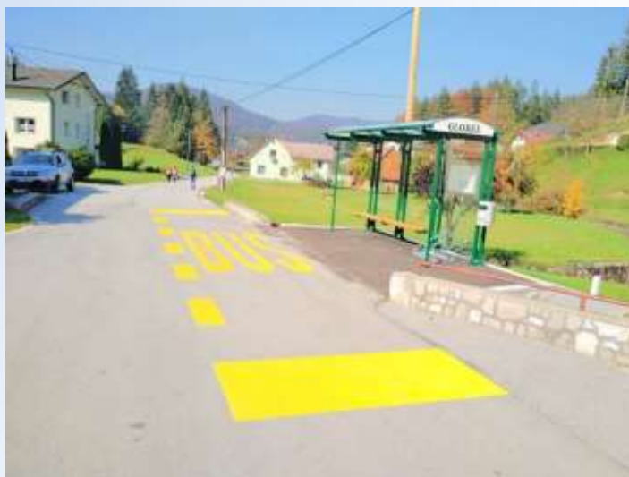
Slika 43: Izgradnja avtobusnega postajališča v Globeli
