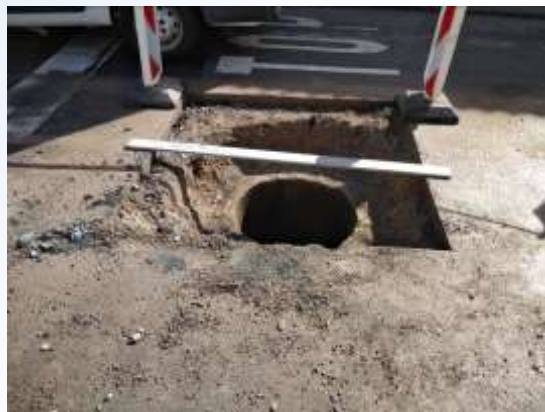
Slika 38: Popravilo jaška na Urbanovi ulici
