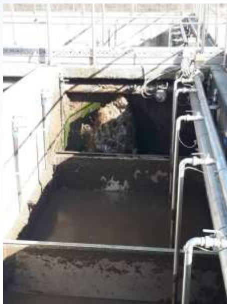
Slika 16: Selektor (aerobni bazen terciarnega čiščenja) na CČN Ribnica
