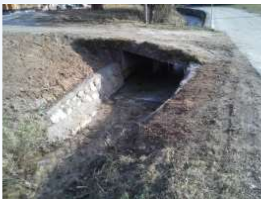
Slika 39: Popravilo podpornega zidu na propustu v Žimaricah
