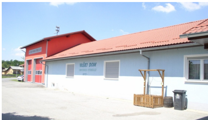
Slika 6.11: Gasilski dom Prvenci-Strelci (levo), vaški dom Prvenci-Strelci (desno).
