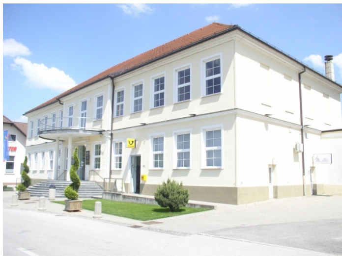
Slika 6.2: Občinska stavba občine Markovci
