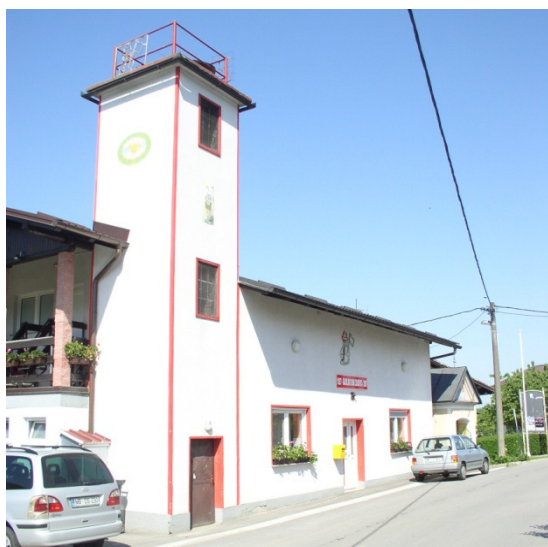
Slika 6.10: Gasilski dom Zabovci.
