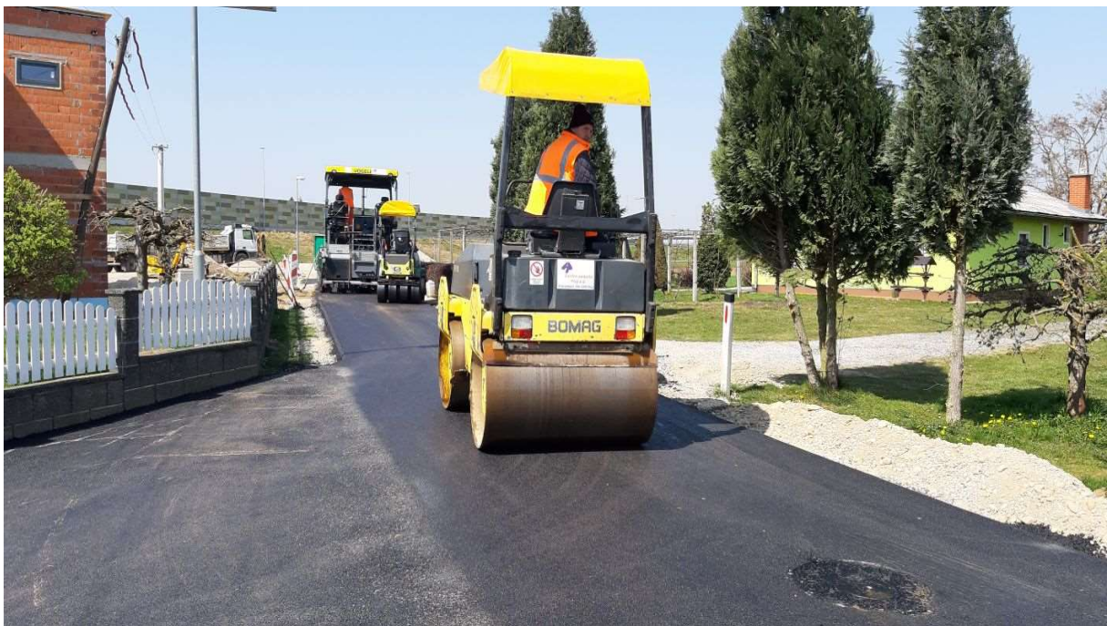
Slika 6: Izgradnja kanalizacije Lancova vas - do avtoceste
