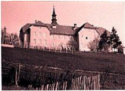
Slika 2.2: Šola pred začetkom obnove in dogradnje
