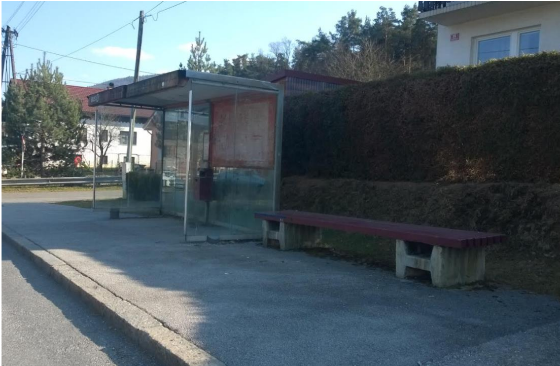
Slika 3: Primer nadstrešnice dotrajanega videza 2
