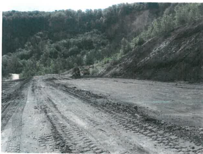
Slika 4. formiranje 1. berme – sanacija brežine
