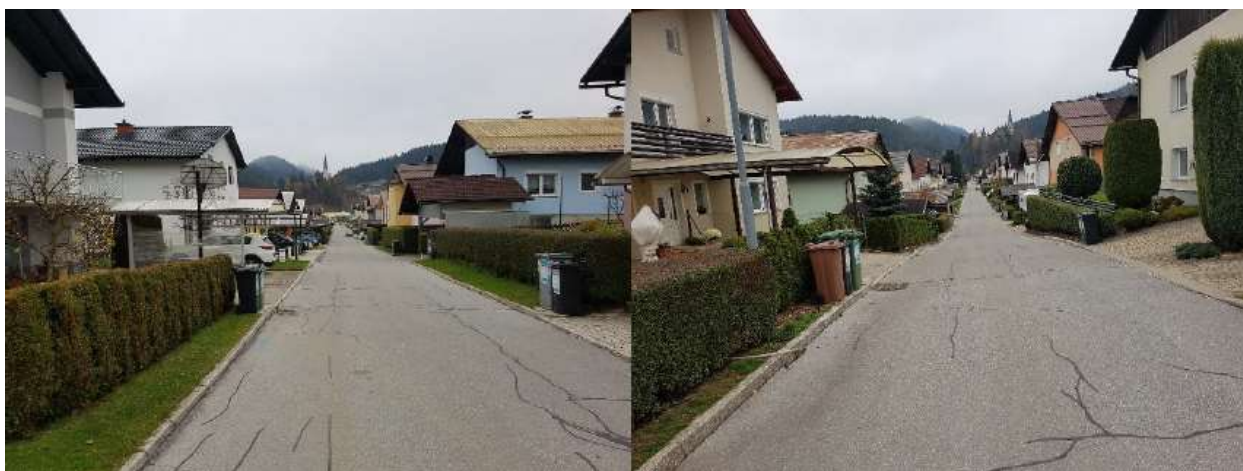
Slika 2: Lokacija predvidene rekonstrukcije kanalizacijskega sistema pod obstoječim cestiščem
