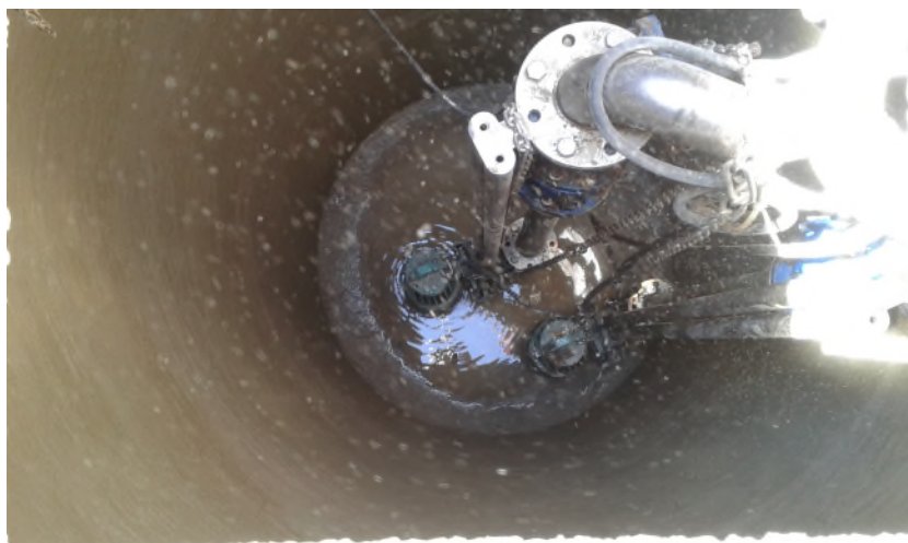
Sanacija črpališča Zgornje Gorje
