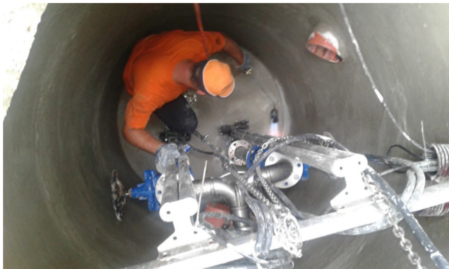
Sanacija jaška črpališča Mevkuž
