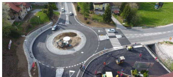
Slika 27: Krožišče v izgradnji
