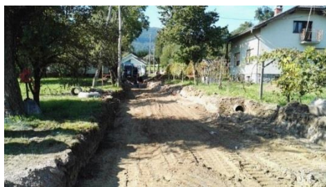
Slika 26: Izvajanje zemeljskih del na rekonstrukciji javne poti Pirš–Dom krajanov–Železinger
