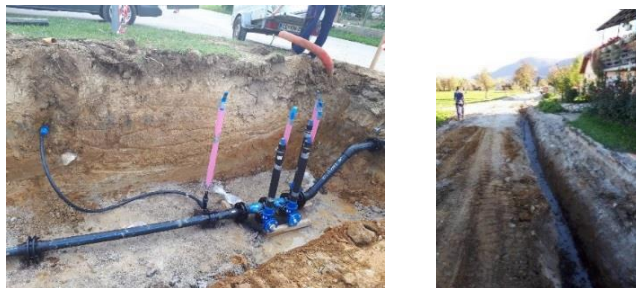
Sliki 52 in 53: Vgradnja vodovodne cevi
