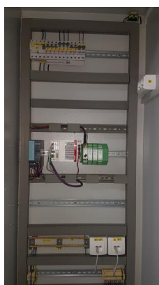
Sliki 55 in 56: Elementi in komponente za avtomatsko nitrifikacijo/denitrifikacijo
