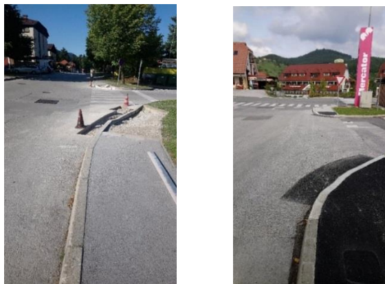
Sliki 40 in 41: Izvedba del prilagoditev in poglobitev pločnikov
