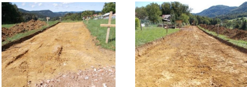
Sliki 22 in 23: Zemeljska dela
