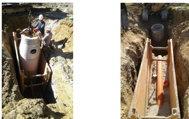
Sliki 24 in 25: Izvedba kanalizacije
