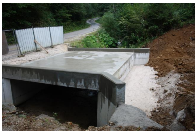
Slika 20: Most čez Ločnico v Skomarju v izgradnji
