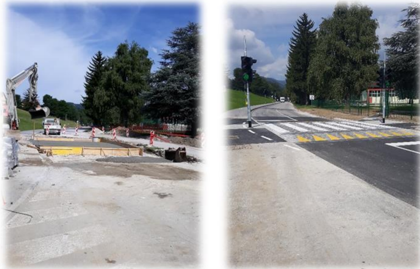
Sliki 29 in 30: Dvignjen prehod v izgradnji in po končanih delih
