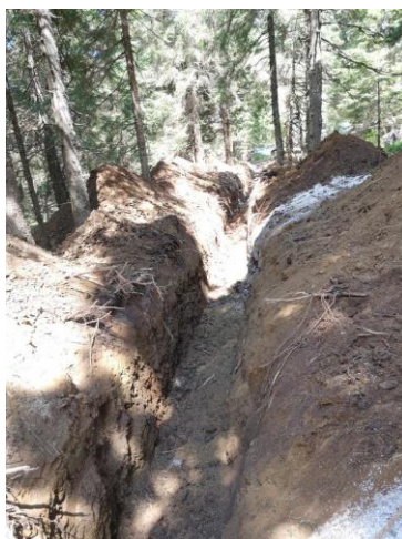
Slika 26: Izdelava priključka za fekalno kanalizacijo
