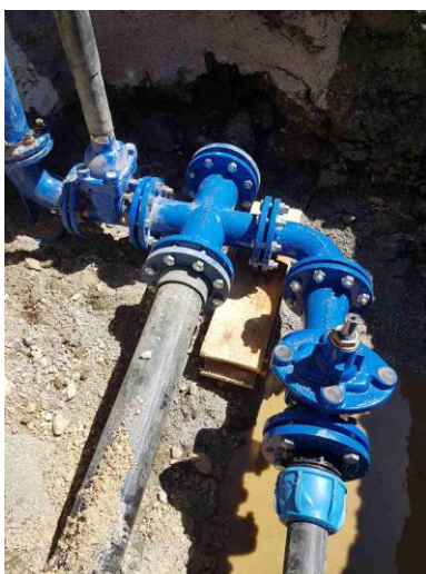
Sliki 22 in 23: Izgradnja priključka za vodo in TK
