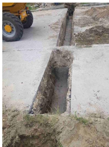
Sliki 22 in 23: Izgradnja priključka za vodo in TK
