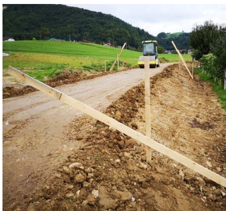
Slika 11: Izgradnja protipoplavnega nasipa
