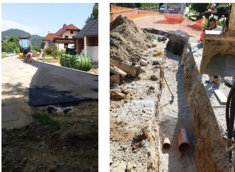
Sliki 8 in 9: Dogradnja meteorne in fekalne kanalizacije Kotnik
