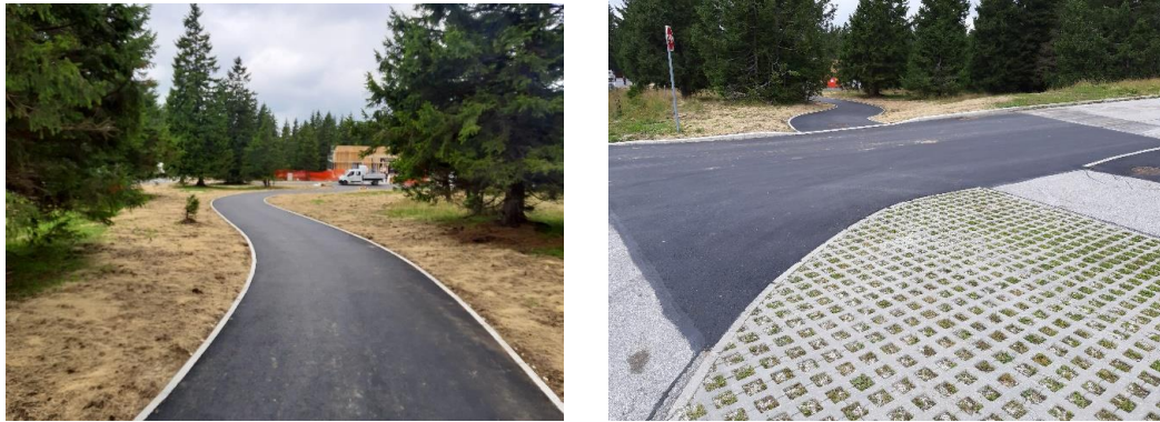
Sliki 27 in 28: Izgradnja dostopne ceste, parkirišča in pešpoti
