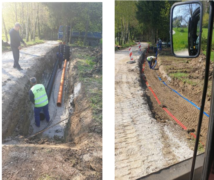
Sliki 6 in 7: Prestavitev kanalizacije
