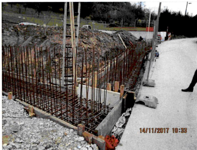
Slika 3: Izvajanje del v varovalnem pasu občinske ceste.
