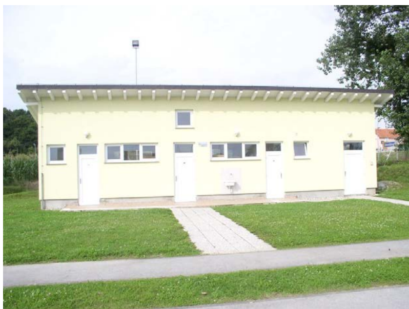
Slika 6.5: Sanitarni prostori športnega igrišča
