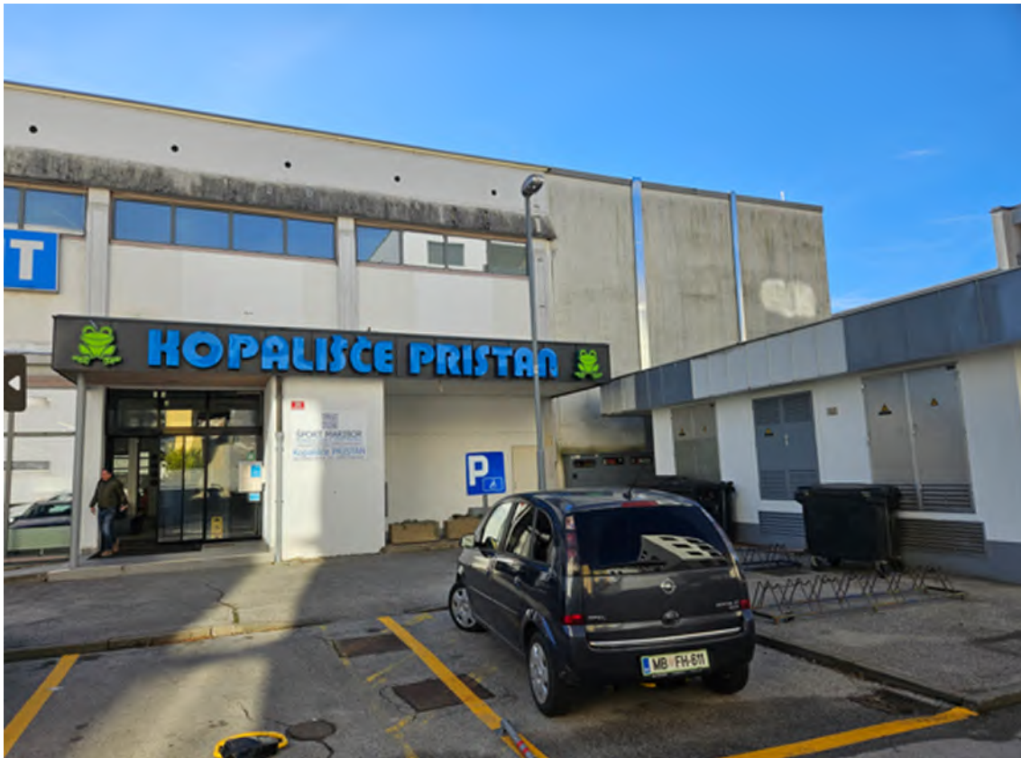
Slika 18: Objekt Kopališče Pristan
