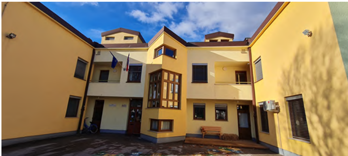
Slika 30: Objekt Dom Antona Skale Maribor
