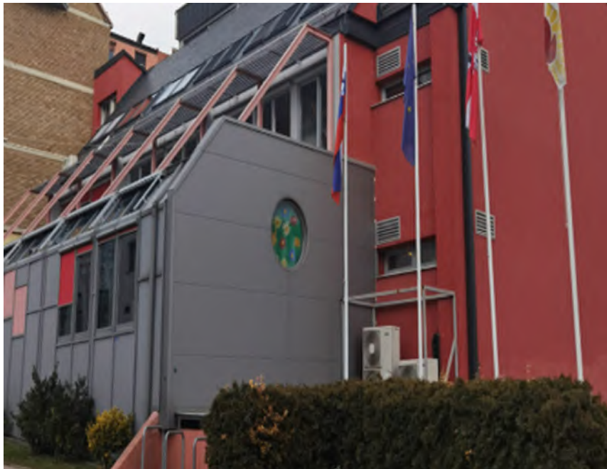
Slika 40: Objekt Vrtec Ivana Glinška uprava
