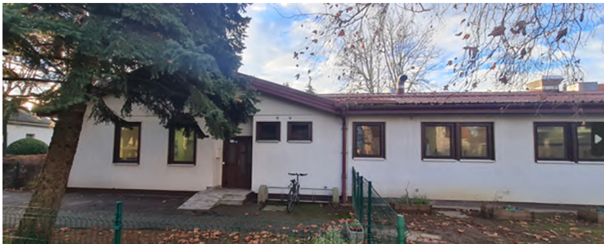
Slika 26: Objekt Vrtec Jadvice Golež uprava
