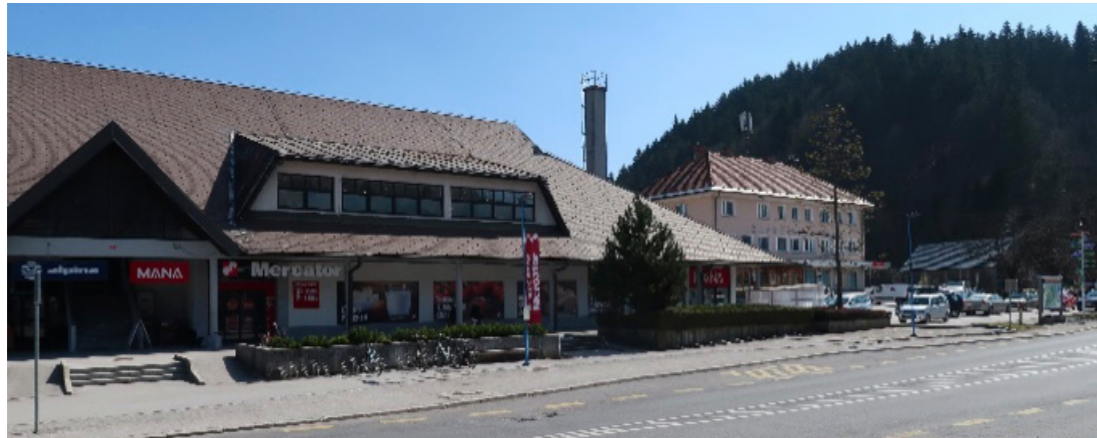
Slika: »Blagovnica«: poslovno trgovski objekt s pošto, več trgovinami, banko in gostinskim lokalom. Julij 2021.
