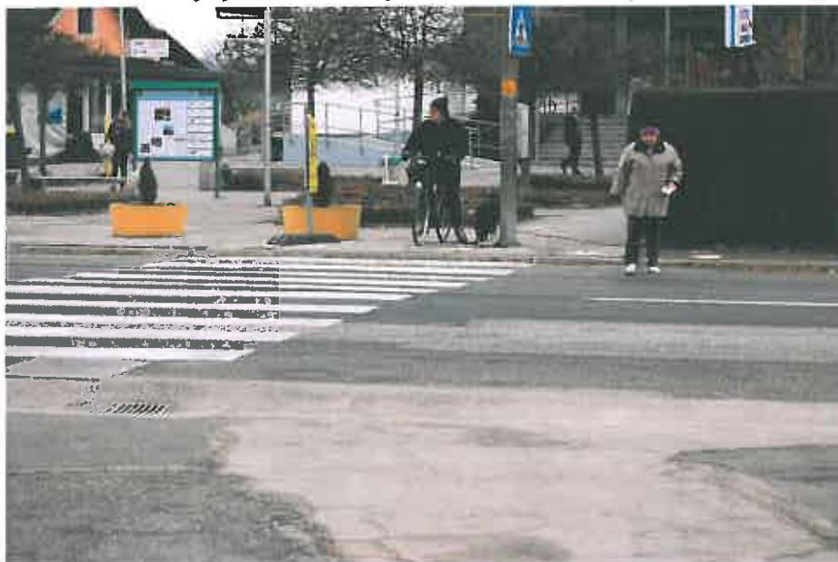
Slika 24: Prikaz manjkajoče klančine za gibalno ovirane osebe neposredno na območju prehoda za pešce
