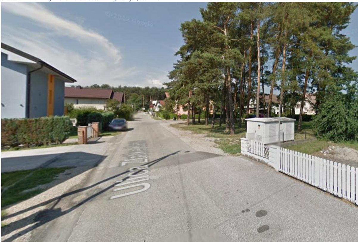
Slika 6-2: Območje razširitve ceste in izgradnja pločnika
