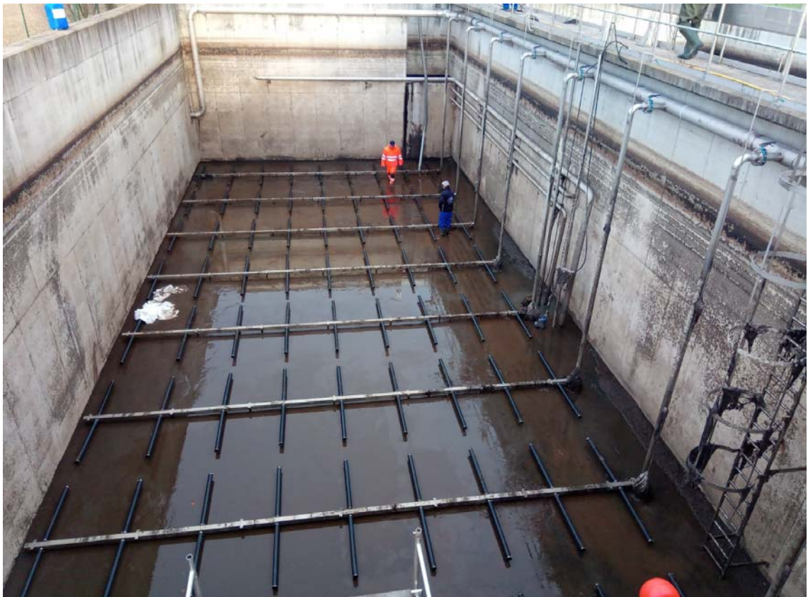
Modernizacija sistema za vpihovanje zraka v SBR1
