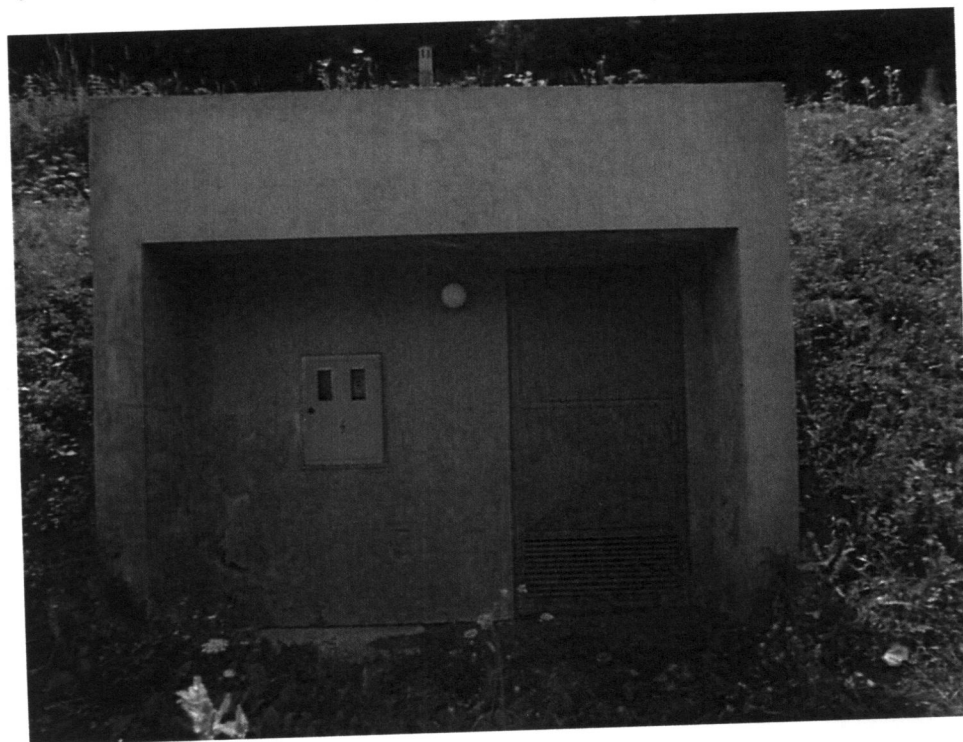
Slika 3-2 Primer objekta brez ograje
