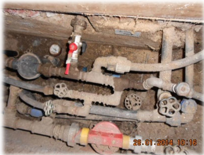
»Predelava« v vodomernem jašku: kje je »skrit« vodomernik
