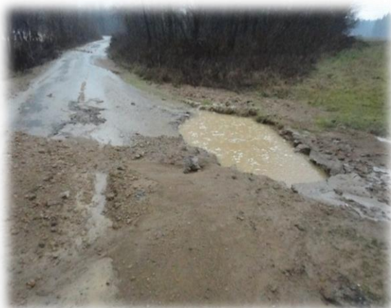
sanacija okvare na glavnem vodu (DN 315) v Slovenski vasi
