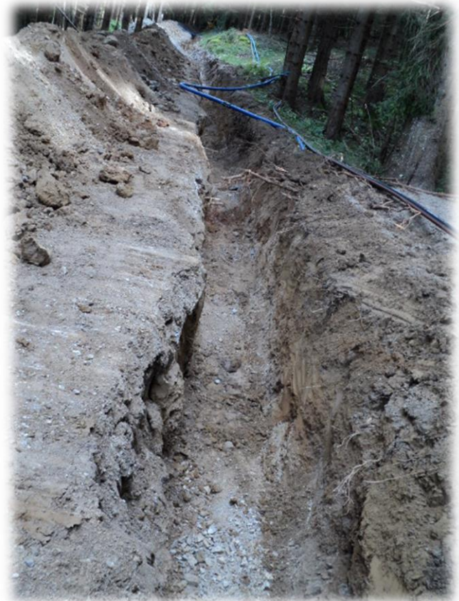
Izgradnja vodovoda Knežja Lipa - Brezovica
