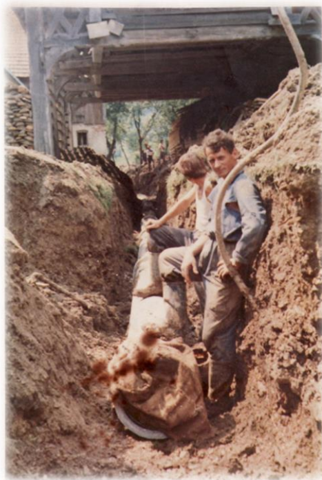
Izgradnja regionalnega vodovoda
