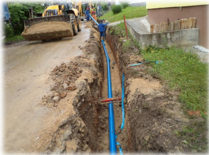
Obnova vodovoda Otavice
