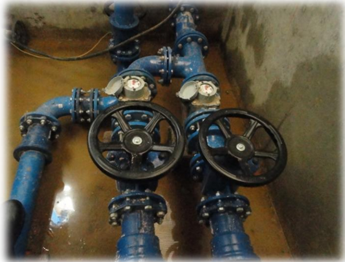
Sanacija vodohrana Mali log
