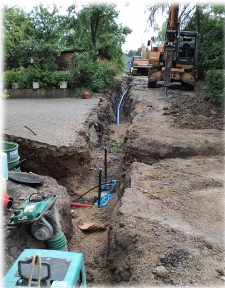
Obnova cevovoda v Dolgi vasi
