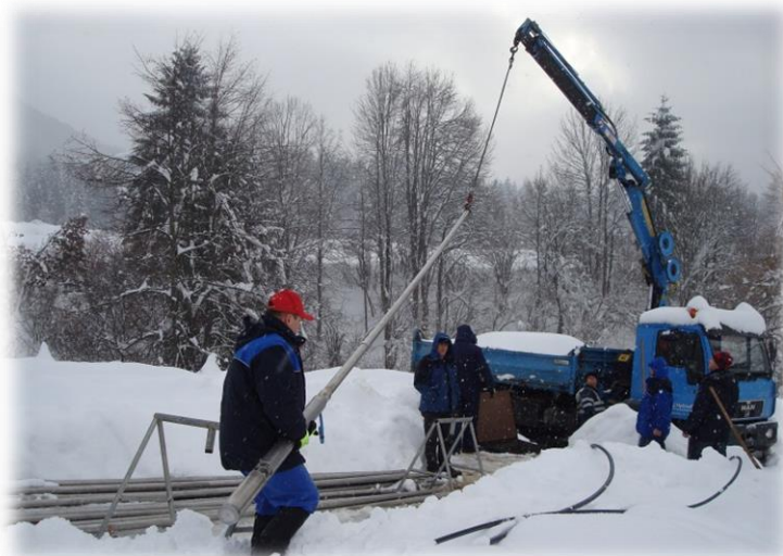
Zamenjava črpalke Spodnji log
