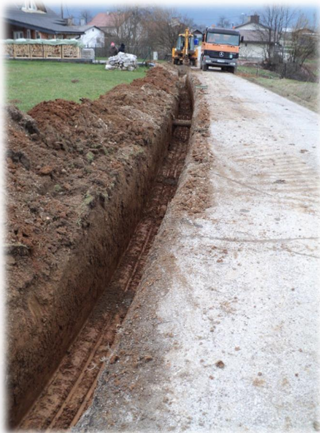
Izgradnja vodovodnega odseka Cvišlerji
