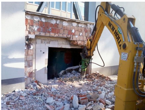
Slika 21: Prebijanje stene na stavbi športnega centra Ribnica
