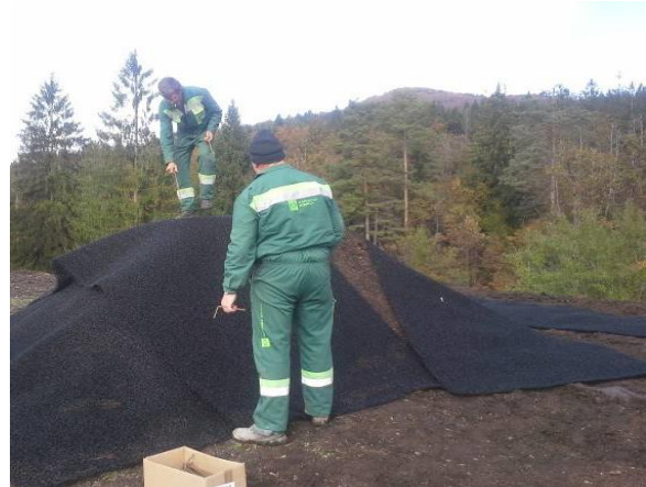
Slika 3: Izdelava kape odplinjevalnega jaška
