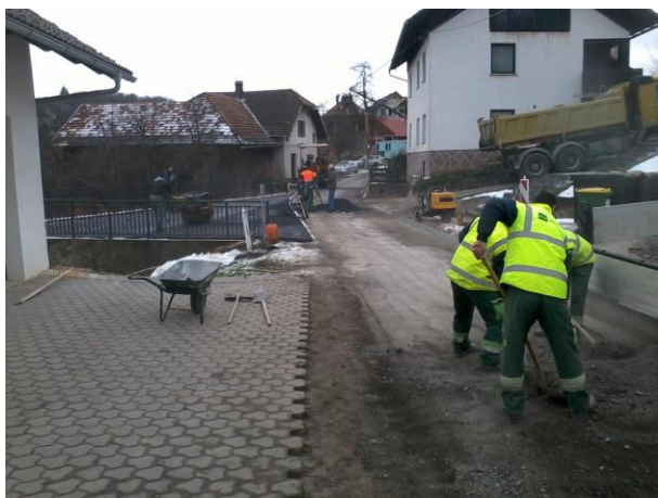
Slika 22: Priprava cestišča za asfaltiranje
