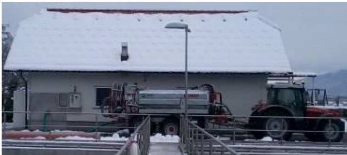
Slika 17: Praznjenje cisterne v zalogovnik grezničnega blata na ČN Ribnica
