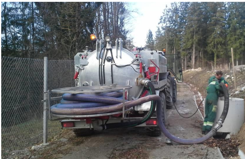
Slika 16: Čiščenje meteorne kanalizacije
