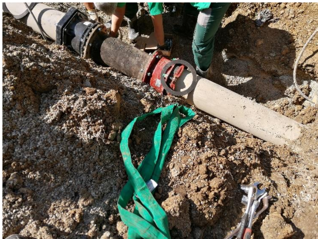
Na sliki: odpravljanje večje okvare na območju Prapreč
