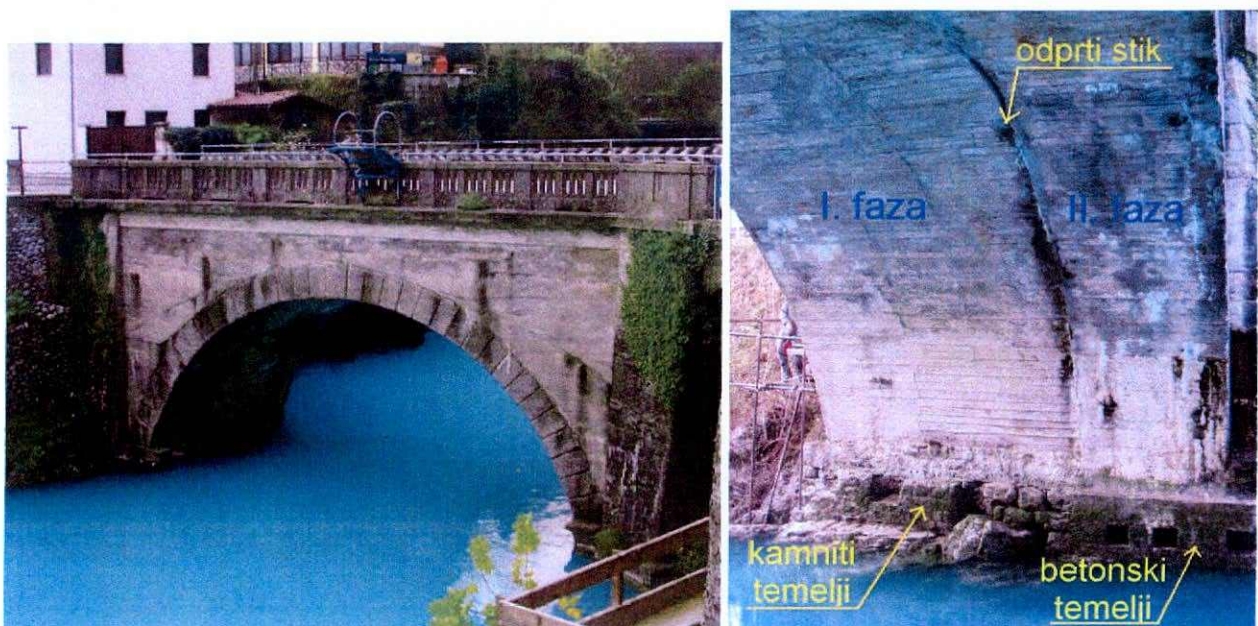
Sliki 1 in 2 – Pogled na most na Soči (GO0133), na cesti R3-603/1041, v km 0,130.
