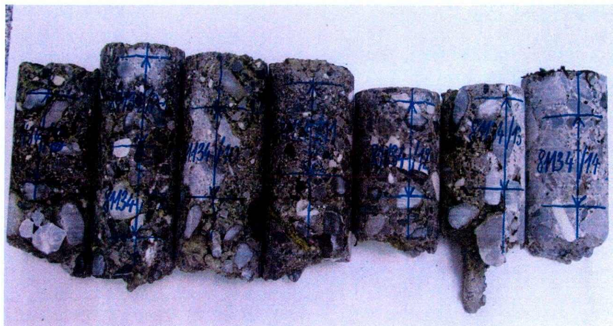
Slika 6– Fotografija valjev odvzetih na gorvodni strani mostu
