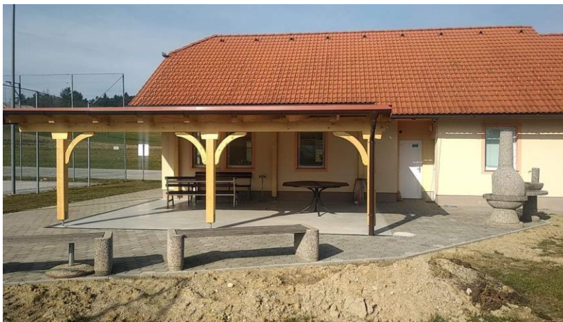
Ureditev nadstreška pri domu.
