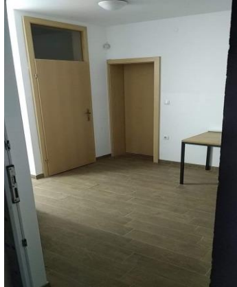
Sanacija sanitarij in vgradnja novih vrat.
