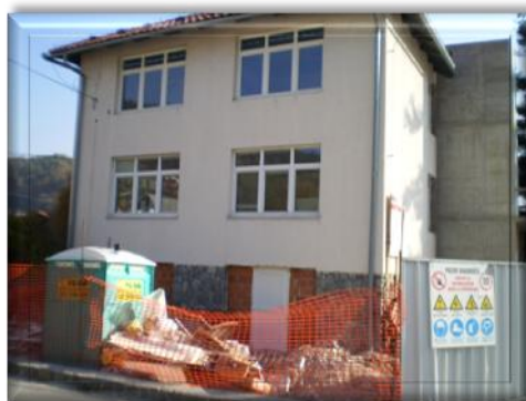
Slika 49: Dela na obnovi zdravstvene postaje Zreče
