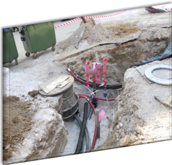
Slika 21 in 22: Sanacija vodovodne napeljave Mladinska ulica 1
