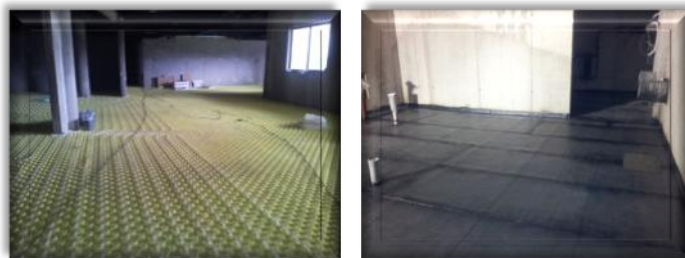
Slika 57 in 58: Izvedene horizontalne hidroizolacije in toplotne izolacije v vseh etažah vključno z estrihi in celotni talnim gretjem
