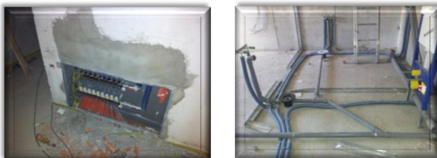
Slika 59 in 60: Strojne in elektro instalacije
