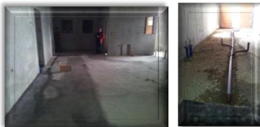
Slika 55 in 56: Dokončana vsa kanalizacija pod nivojem
