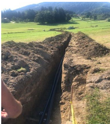
Slika 89: Menjava cevi Stranice-Korošec
