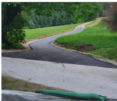
Slika 77: Asfaltirana cesta pri Petelineku
