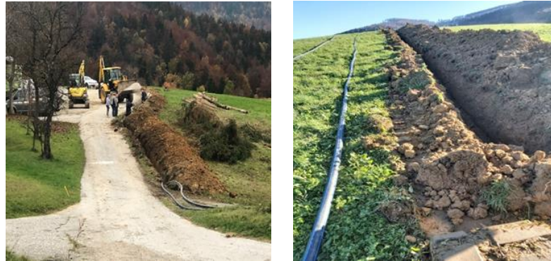
Sliki 90 in 91: Dela na vodovodu Čretvež
